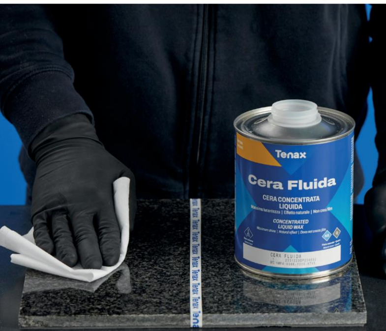
اعمال واکس روی سطح سنگ
