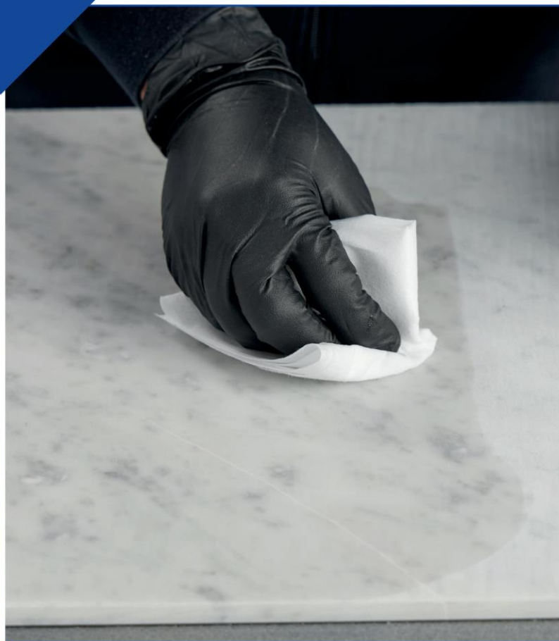
محصول را پشت سنگ در حال نصب اعمال کنید
